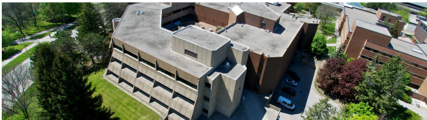
Les installations du SWORDC sur le campus de l'Université de Waterloo. Photo: SWORDC
